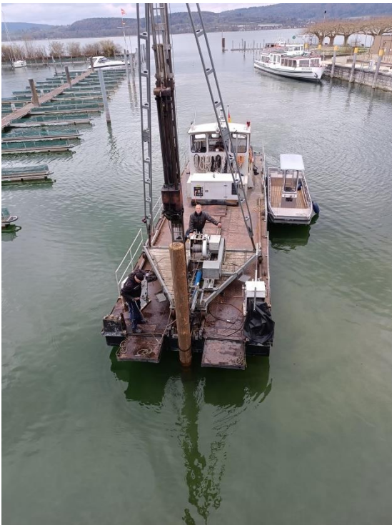
Rammerschiff in Aktion
