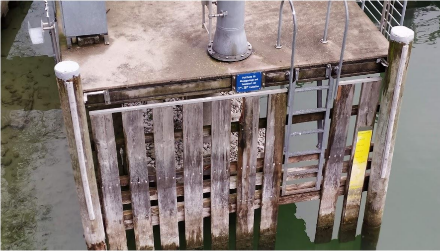
Die alte Absauganlegestelle
