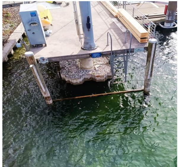
Alles alte ist weg ,neue Dalben gerammt
